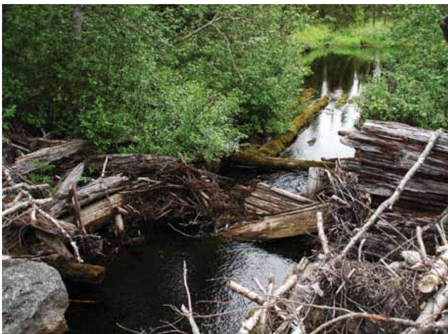
Figur 7. Nedströms damm-öppningen syns rester av ett skibord i form av stockar som bör ha haft till funktion att förhindra att virke fastnar i botten. Detta tyder på att flottning genom dammen förekommit.
