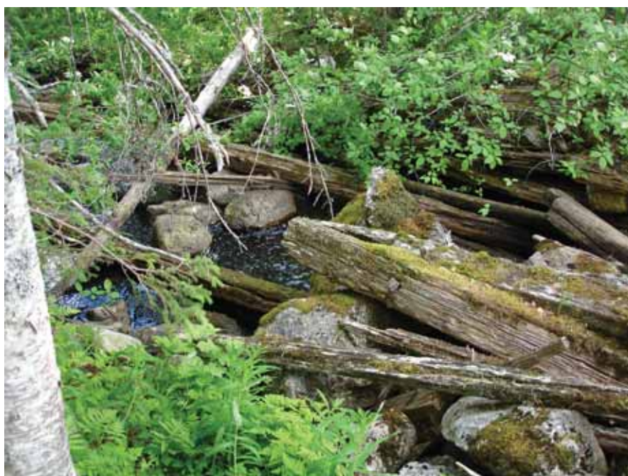
Figur 8. Rester av flottningsdamm vid Angsjöns utlopp.
