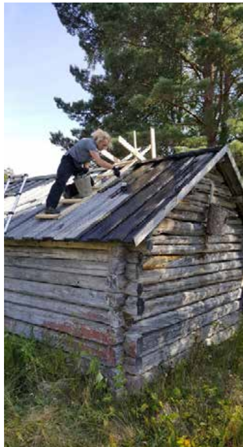
Taket på ladan vid Åsbyvallen tjäras.
