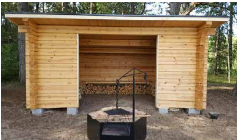
Nytt tillgänglighetsanpassad vindskydd vid Strångnäs.
